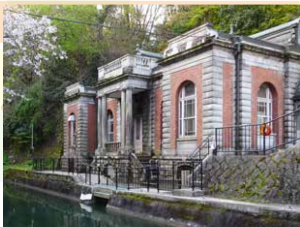
旧御所水道ポンプ室 画像提供:京都市上下水道局
